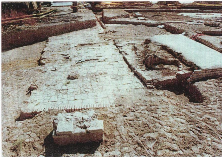
کف آجرفرش پیش ایوان مسجد - مدرسه
