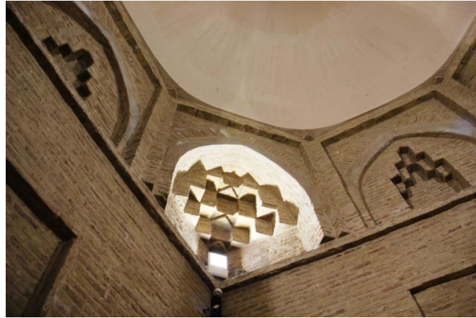
تصویر ۳۱: سقف گنبدی و سه کنج های مقرنس آجری، انتقال از چهارضلعی به دایره (نگارنده)
