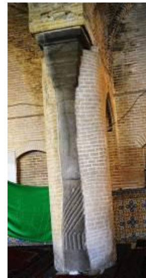
شکل ۷ ستونی که هنوز نیمه آن در داخل جرز آجری قرار دارد. (از نگارنده)
