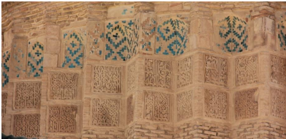
تصویر ۳۵: تزیینات آجرکاری زیر گیلویی و کتیبه‌های کوفی بالای برج (نگارنده)
