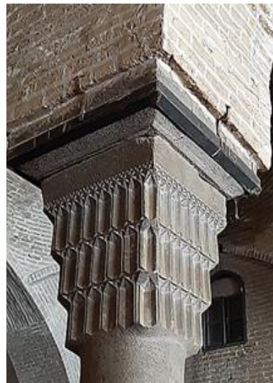
شکل ۸ نمایی از یکی از سرستون های آجری. (از نگارنده)
